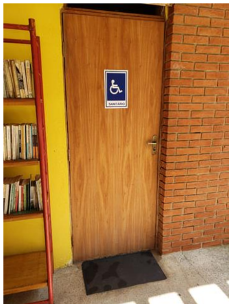
Figura 42: Antes placa do banheiro acessível.
