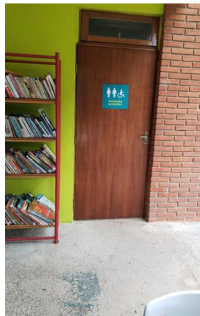
Figura 43: Depois placa do banheiro acessível.
