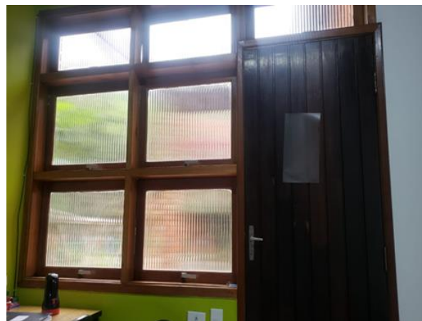
Figura 37: Depois da Manutenção das janelas.
