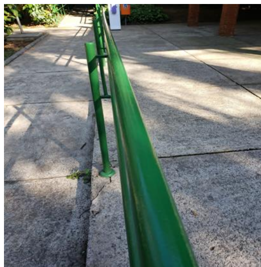
Figura 33: Depois das pinturas nos corrimãos
